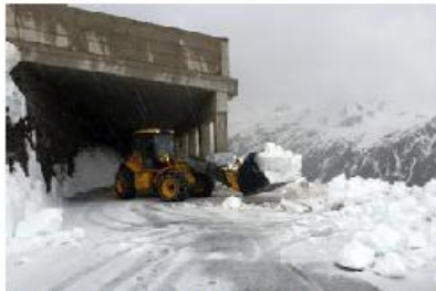
Pontedilegno: lavori ad alta quota per il Gavia. FOTO PING VECLANI
